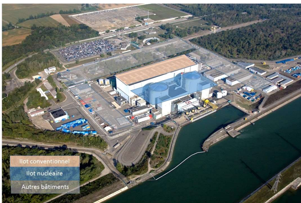
Figure c Vue des ilots conventionnel et nucléaire de l'INB n°75
