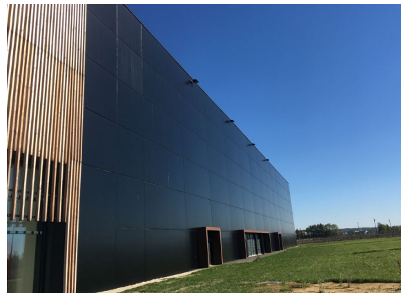
Base nationale de maintenance nucléaire de Saint-Dizier
