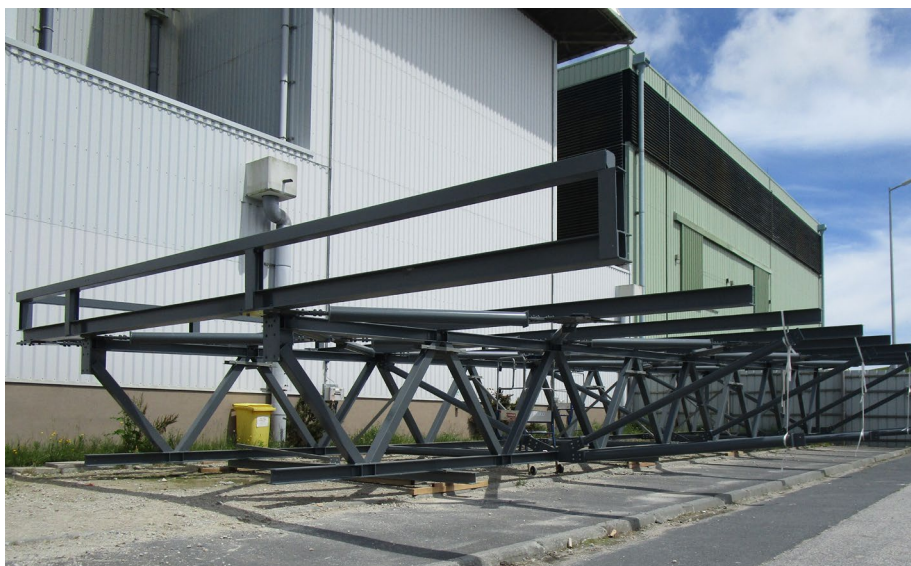
Charpente édifée par Ateliers Bois, entreprise localisée en Haute-Marne.
