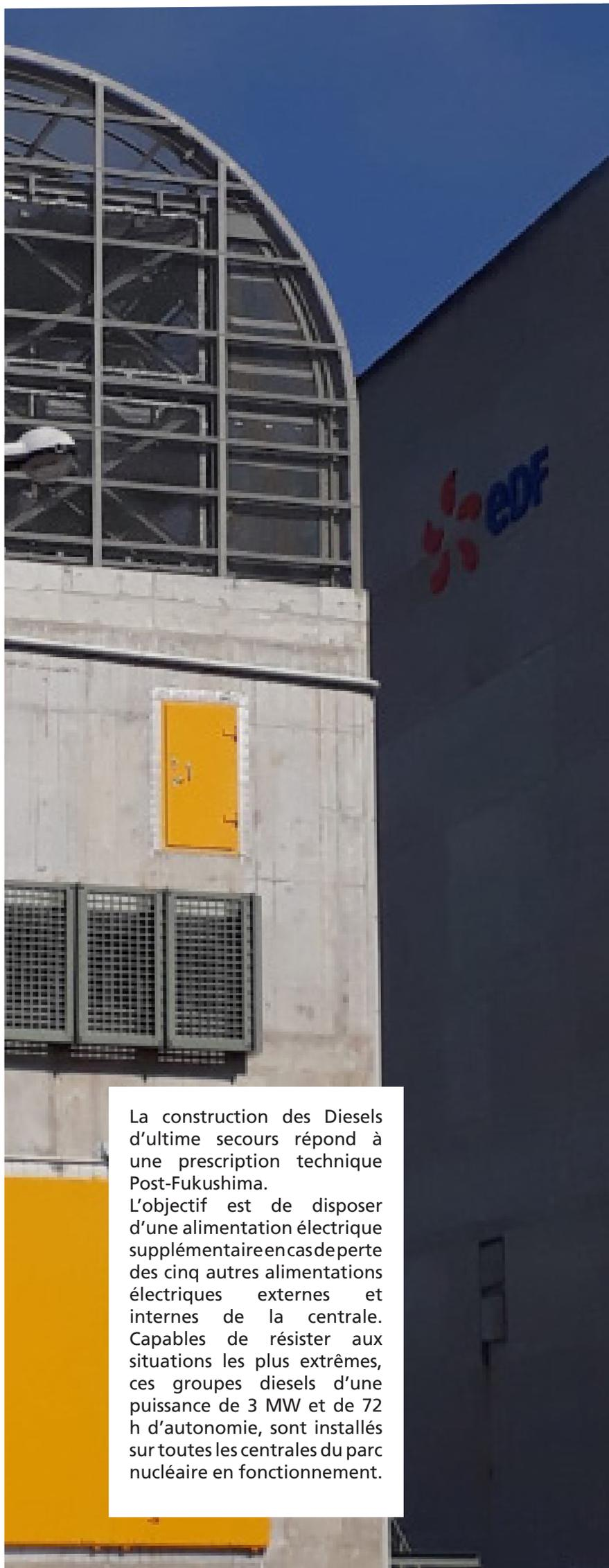
La construction des Diesels d'ultime secours répond à une prescription technique Post-Fukushima. L'objectif est de disposer d'une alimentation électrique supplémentaire en cas de perte des cinq autres alimentations électriques externes et internes de la centrale. Capables de résister aux situations les plus extrêmes, ces groupes diesels d'une puissance de 3 MW et de 72 h d'autonomie, sont installés sur toutes les centrales du parc nucléaire en fonctionnement.
