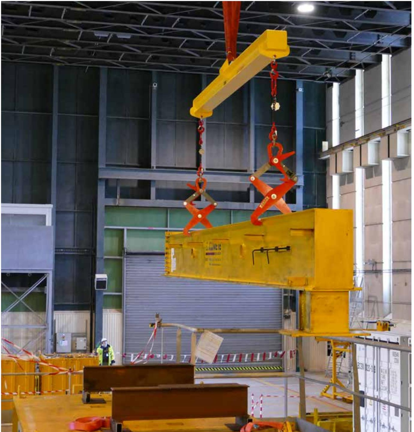
Evacuation de poutres métalliques, de près de 5 tonnes, vers l'installation de fusion de Centraco exploitée par Cyclife France
