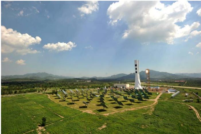
simulations numérique du groupe EDF, la production d'électricité à partir de miroirs réfléchissants et de stockage de l'énergie sous forme d'huile et de vapeur. Ce dispositif innovant permet de lisser la production d'électricité et de répondre aux problèmes d'intermittence de l'énergie solaire.
