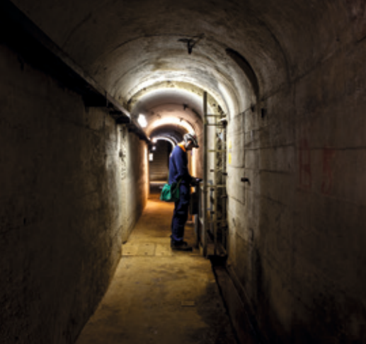
Agent EDF intervenant sur les installations dans le cadre de la tournée d'auscultation
