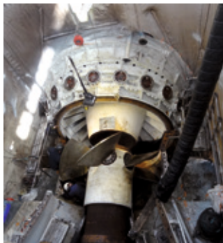
Rénovation du groupe de production n° 2
