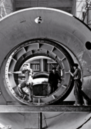
Construction du barrage (1954-1957)
