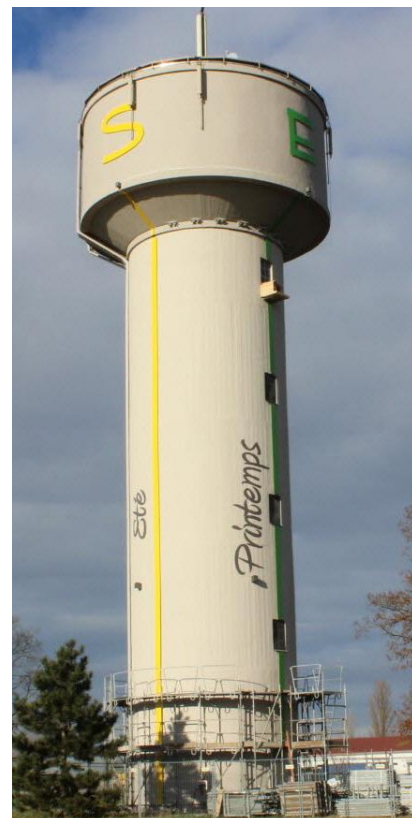
Château d'eau de Fessenheim
