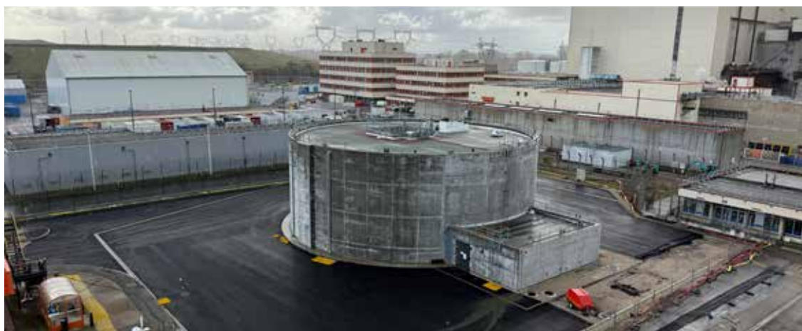
La bâche d'appoint en eau ultime finalisée
