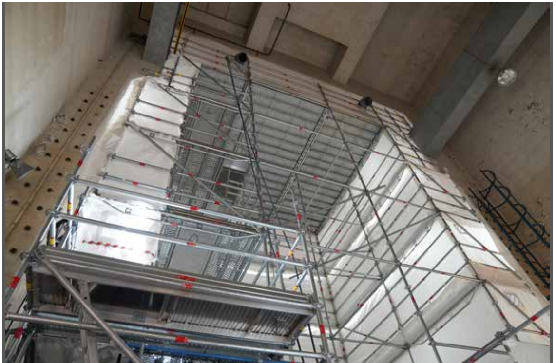
Montage du sas de désamiantage en 355
