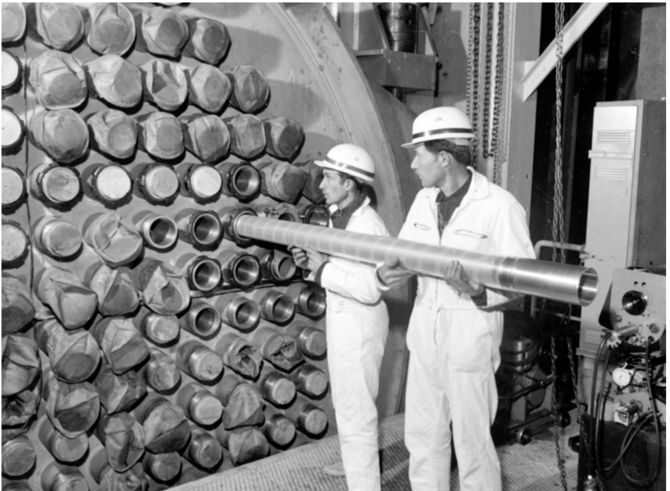
Face de chargement du combustible lors de la construction.
