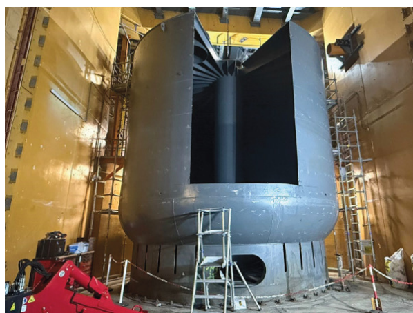
Découpe d'un réservoir de plus de 7 mètres de haut et près de 7 mètres de diamètre.
