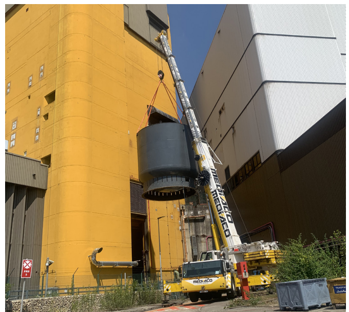
La cuve de 36 tonnes est soulevée de plusieurs mètres de haut
