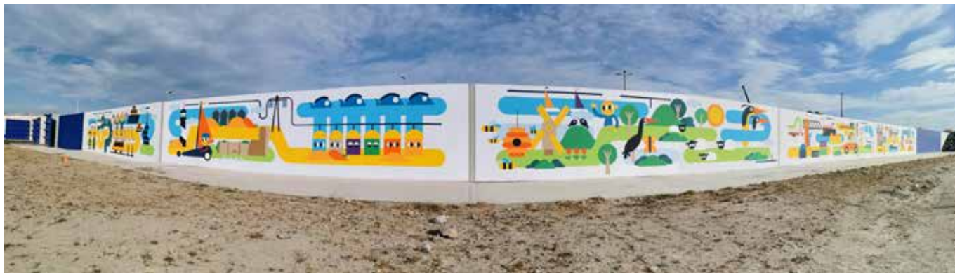
Protection périphérique inondation mise en œuvre depuis fin 2022
