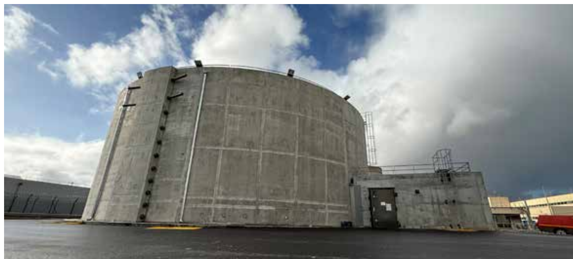
La bache du dispositif Appoint en Eau Ultime (APU) pour les unités de production n°1 et 2, finalisée.
