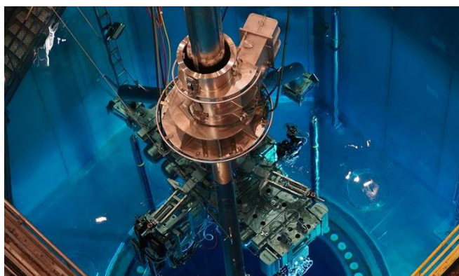
L'un des 3 examens règlementaires : l'inspection de la cuve du réacteur.
