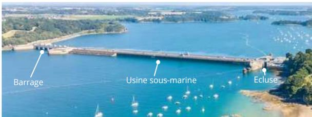
**Usine** : 390 m de long | 33 m de large | 24 groupes de production d'électricité de 10 MW chacun.
