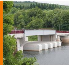
*Barrage de la Ravivière, vue amont, création d'un évacuateur de crue en forme de touche à piano (Piano Key Weir, PKWeir).*
