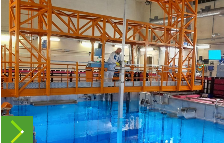
Déchargement du combustible en vue de son renouvellement
