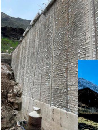
Vue aval du barrage d'Izourt (46 mètres de hauteur, 1645 mètres d'altitude, capacité de 7,54 millions de m<sup>3</sup> d'eau).
