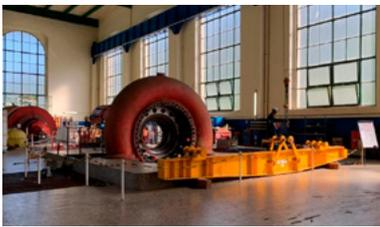
Il comprend la reconstruction de l'alternateur, la reprise du vannage, le démontage du stator qui sera remplacé, le reconditionnement des pôles du rotor et le démontage de la turbine. Au remontage, la turbine et l'arbre de la turbine seront neufs. Les équipes d'EDF Hydro Luz-Pragnères, l'équipe d'intervention mécanique Lau-Balagnas, le Service de Réparation Hydraulique, le Centre d'Ingénierie Hydraulique d'EDF et Dalkia vont œuvrer pendant plus de 6 mois.
