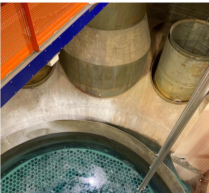
Sur cette photo on aperçoit distinctement l'intérieur de la cuve du réacteur SUPERPHENIX. Le faux sommier du combustible est visible au niveau des parties alvéolées en fond de cuve.
