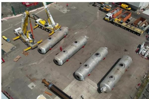
Dépose des derniers groupes sècheurs-surchauffeurs en salle des machines : une opération à 350 tonnes !
