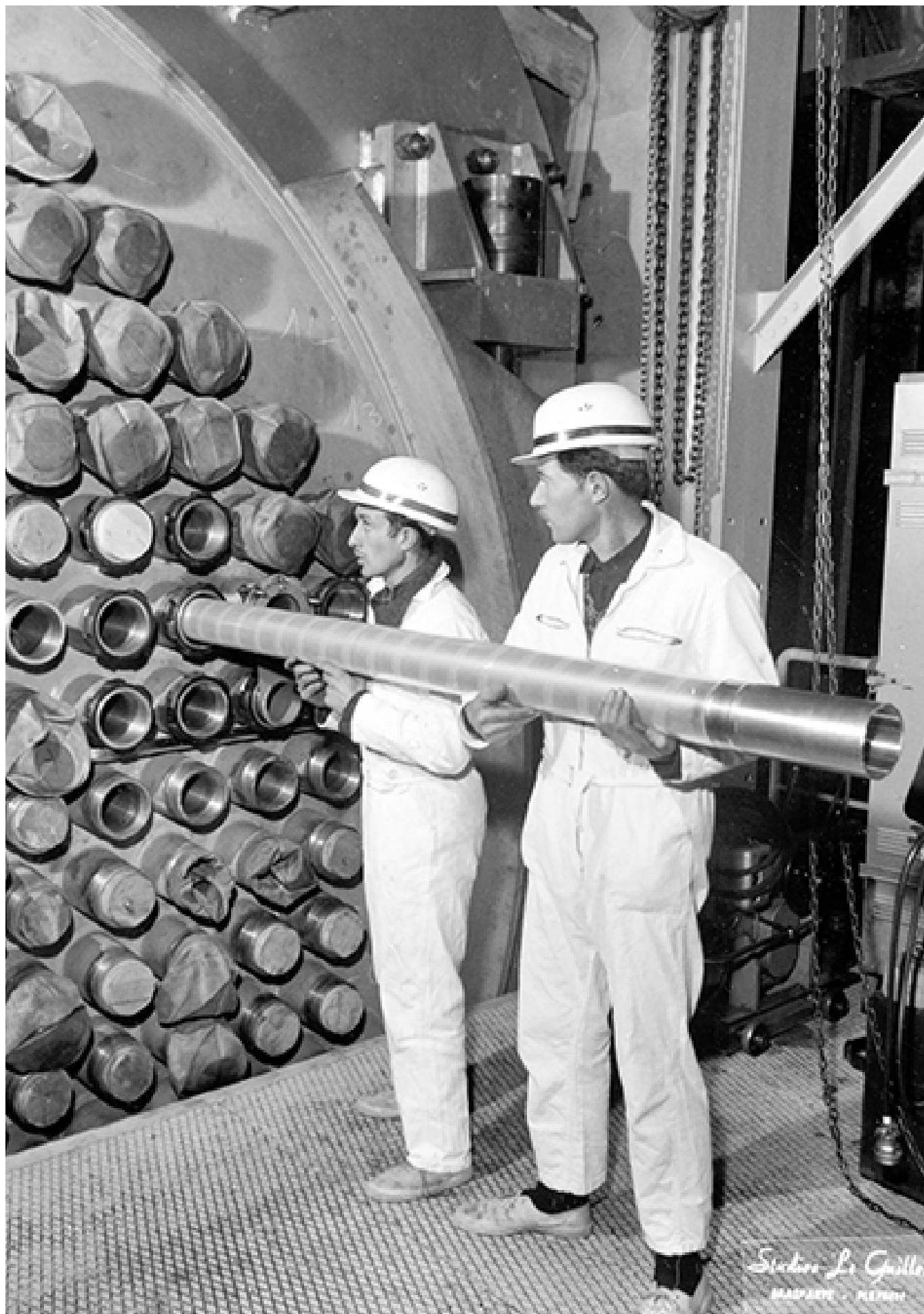
Face de chargement du combustible lors de la construction.
