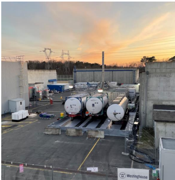
Équipements de préparation des solutions chimiques
