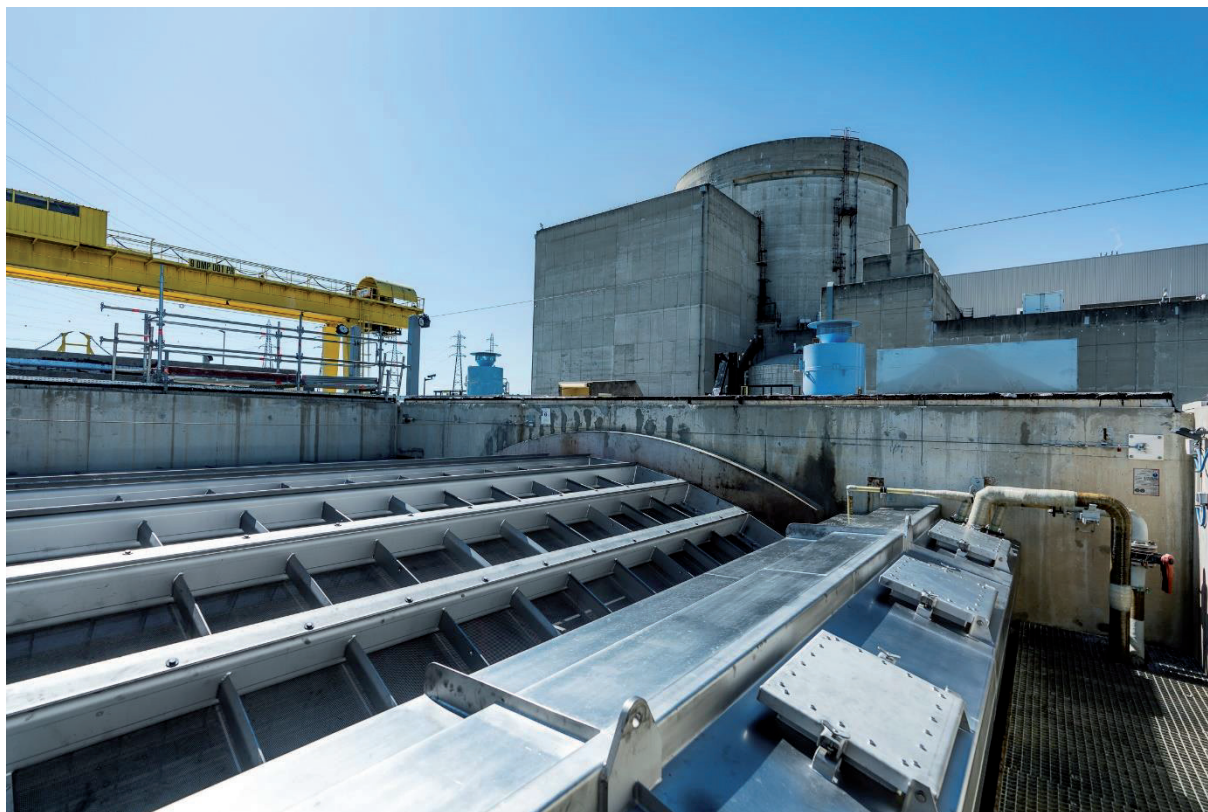
Station de pompage : les tambours filtrants
