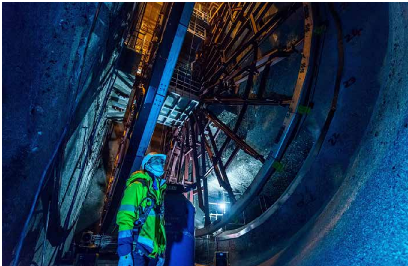
Remplacement du tambour filtrant de l'unité de production n°1.
