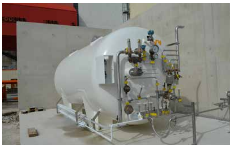
« Rénovation du parc à gaz. »
