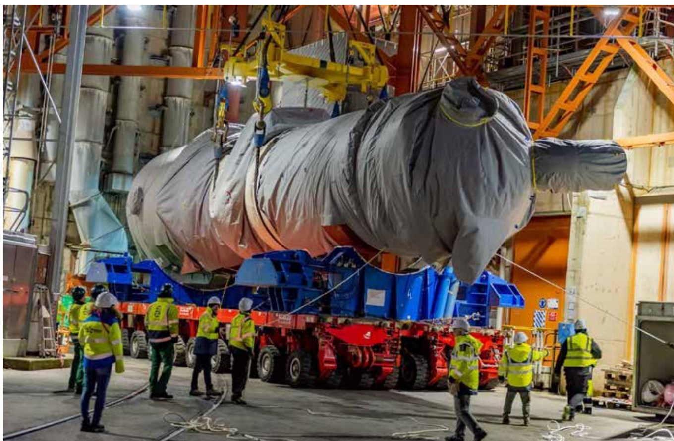
Remplacement des trois générateurs de vapeur de l'unité de production n°6.
