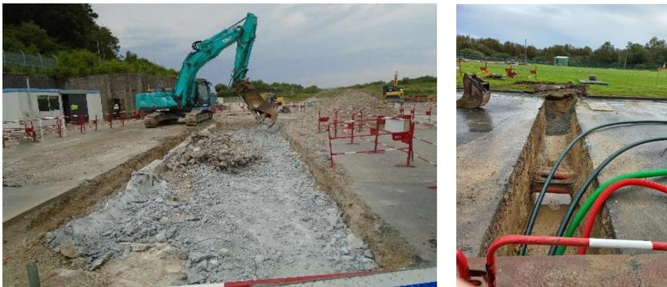
**Figure 17 : Retrait des rails et pose de chambres de tirage**
