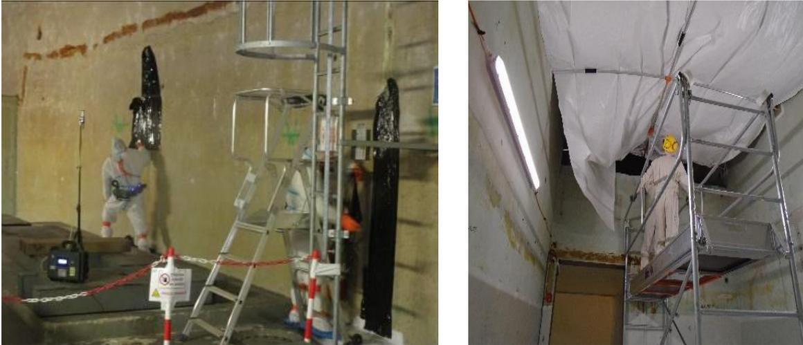
**Figure 13 : Désamiantage (par liquéfaction) et mise en place d'un sas de confinement**
