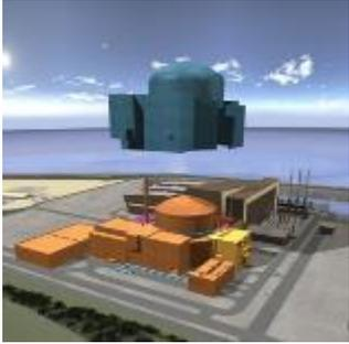
Double enceinte de confinement dont la coque résiste au crash d'un avion
