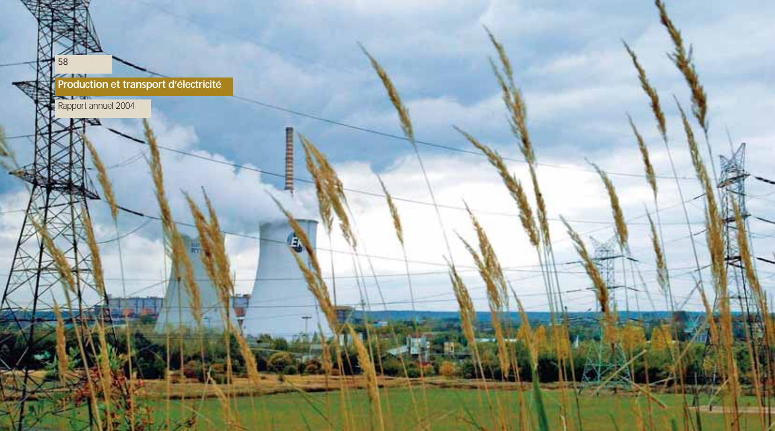
La centrale thermique à flamme de Rybnik, en Pologne.
