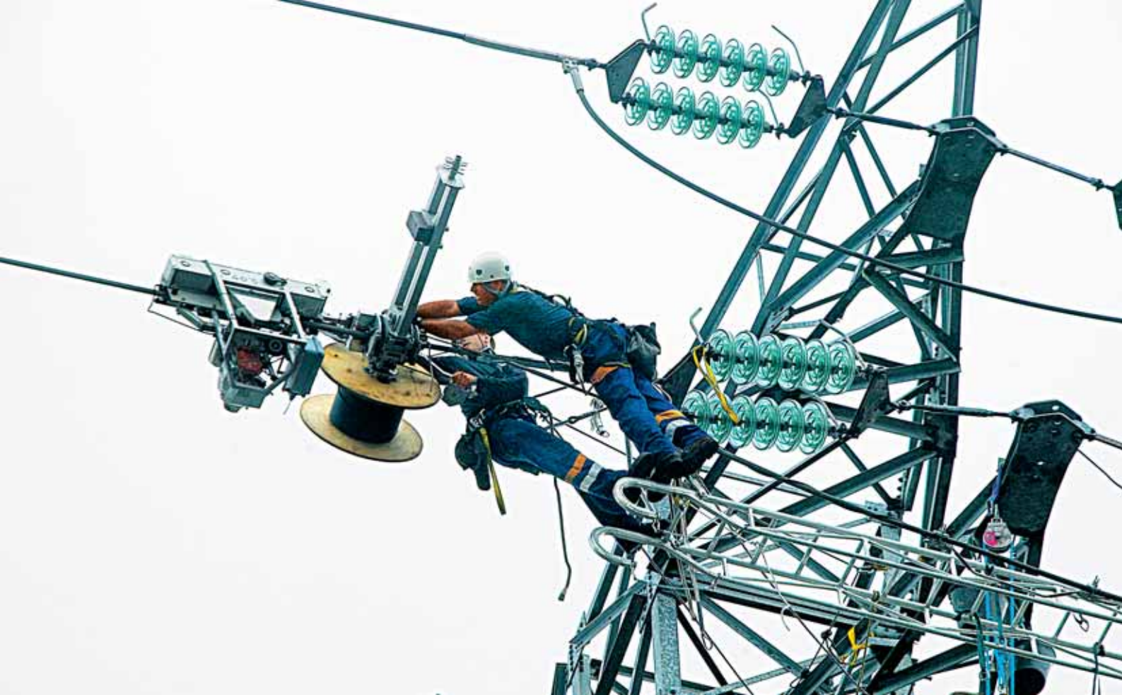
Pose de fibres optiques (COE) sur le réseau Bretagne Sud, en août 2004.
