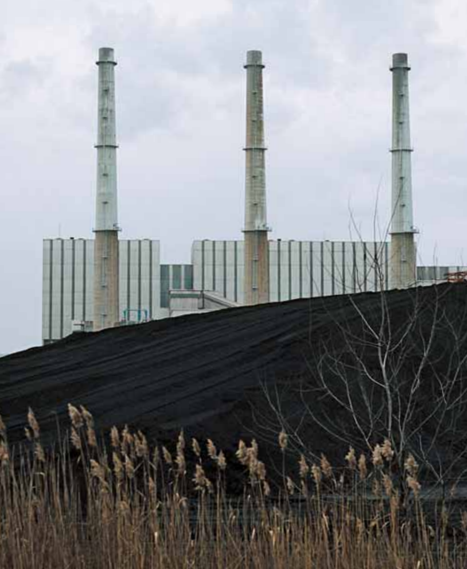
La centrale thermique à flamme de Blénod-les-Pont-à-Mousson, en Meurthe-et-Moselle, prépare sa visite décennale.
