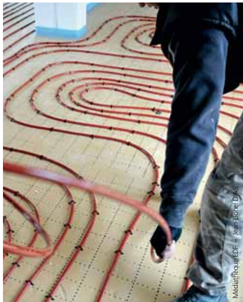
Installation d'un plancher chauffant relié à une pompe à chaleur. Une des solutions énergétiques qu'EDF propose à ses clients.
