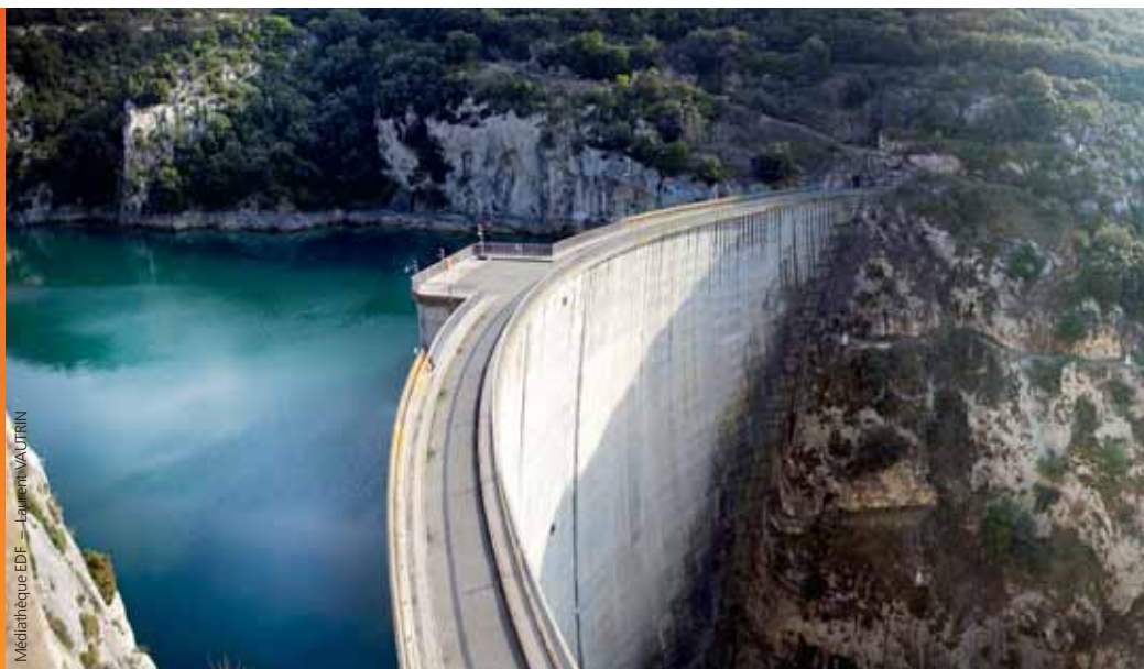
Barrage de Sainte-Croix dans les Alpes. Le groupe EDF est le premier producteur hydroélectrique de l'Union européenne.
