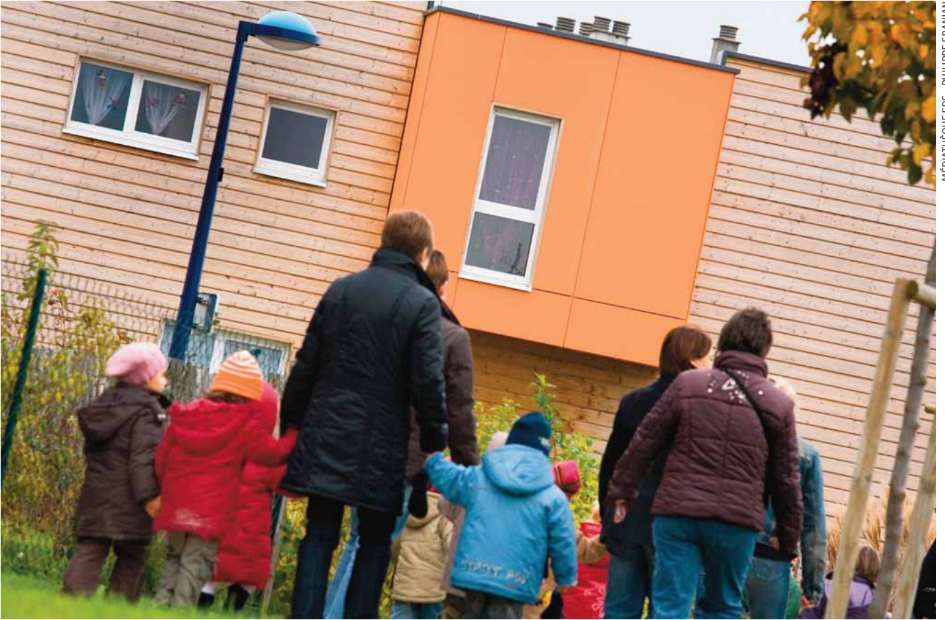
Cité-jardin du Petit-Béthény, France. Les maisons sont à ossature bois, l'isolation est très poussée. Dans ces logements sociaux, la consommation d'énergie est réduite de 35 %.
