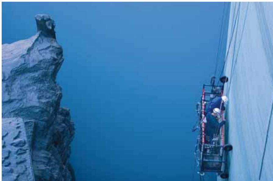
Inspection du parement du barrage de Plan-d'Aval à Aussois, lors de sa vidange décennale de 2007.
