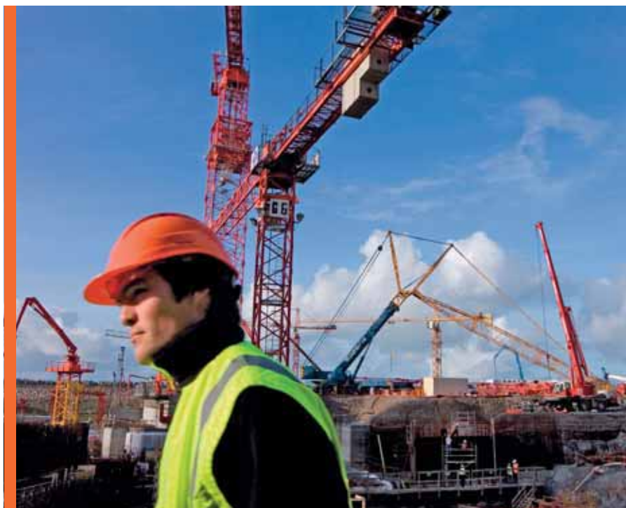
Lors du coulage du premier béton, sur le chantier de construction de l'unité type EPR à Flamanville.
