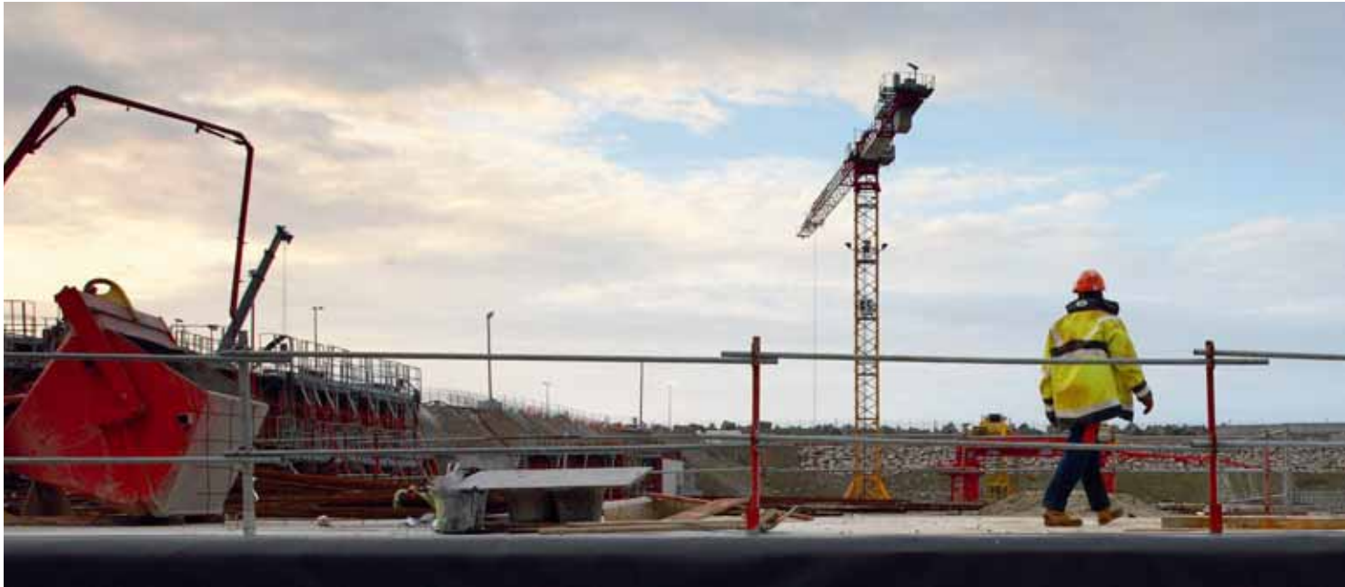
Chantier de construction de l'unité EPR de Flamanville. La production nucléaire d'électricité présente l'avantage de ne dégager aucune émission de CO 2 .
