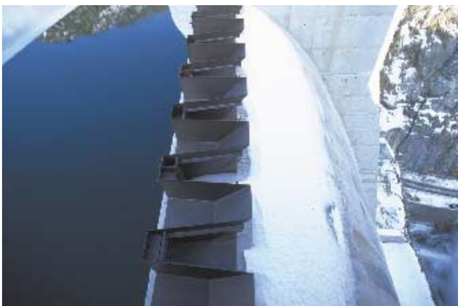
■ Aménagement hydraulique de Puy Laurent
