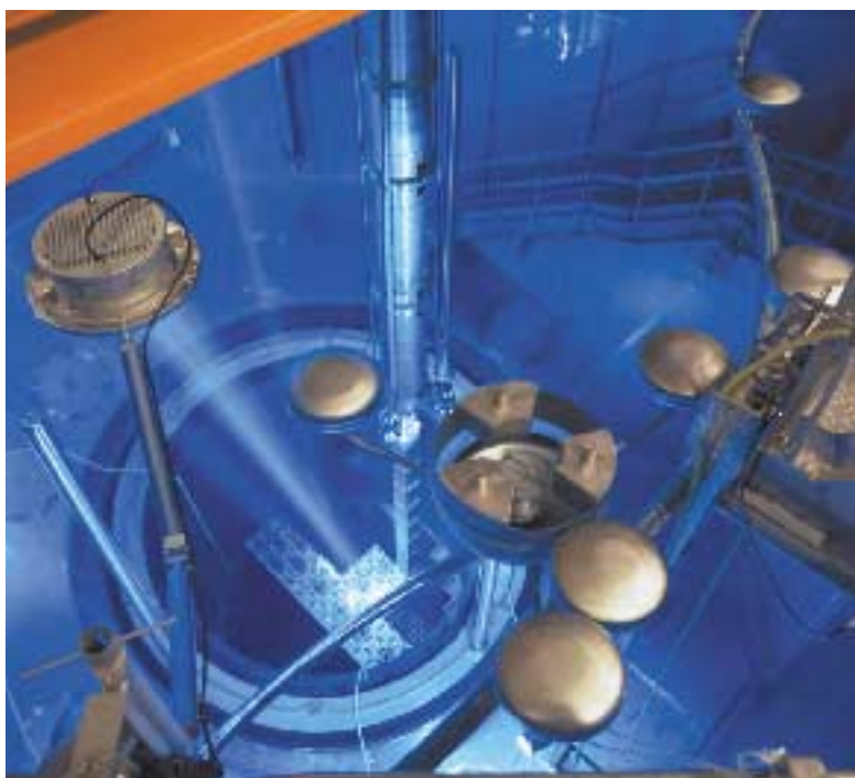
■ Chargement du cœur réacteur de la tranche 2 de la centrale nucléaire de Ling Ao.
