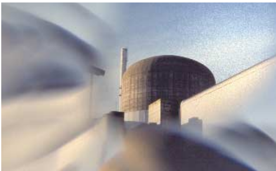
■ Dôme d'un bâtiment réacteur à la centrale nucléaire de Paluel, certifiée ISO 14 001.
