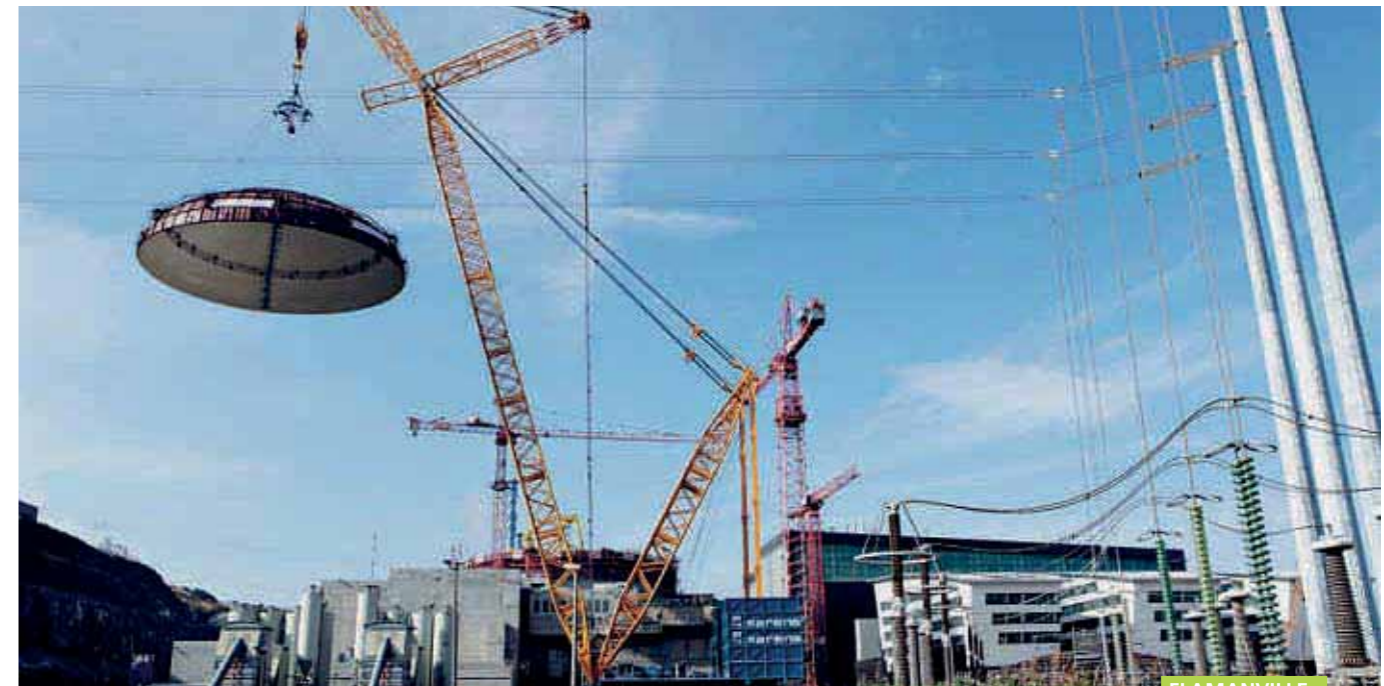
FLAMANVILLE : POSE DU DÔME DE L'EPR
