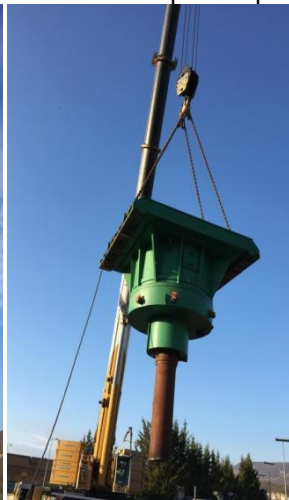
Evacuation du dégrilleur (28 tonnes) et du moteur de la pompe (28 tonnes) de la station.
