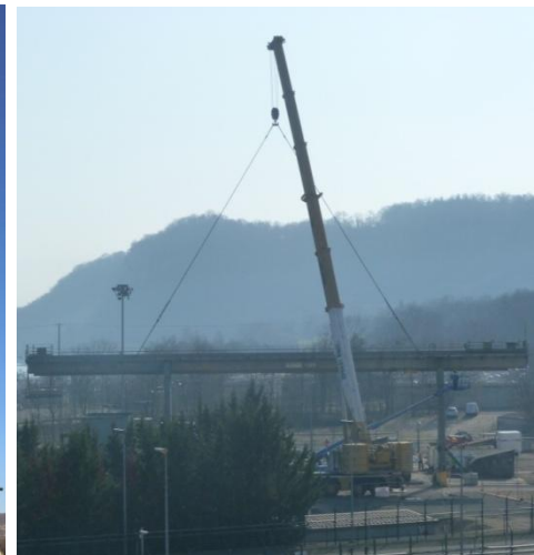
Dépose du pont de la station de pompage
