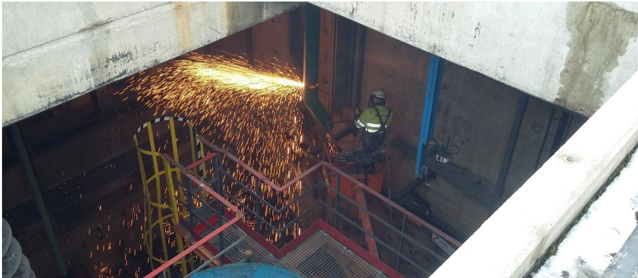
Découpe des parties électromécaniques dans la station de pompage
