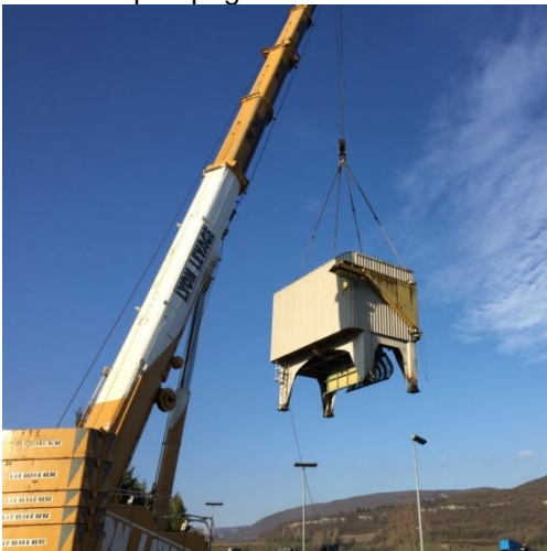
Evacuation du dégrilleur (28 tonnes) et du moteur de la pompe (28 tonnes) de la station.
