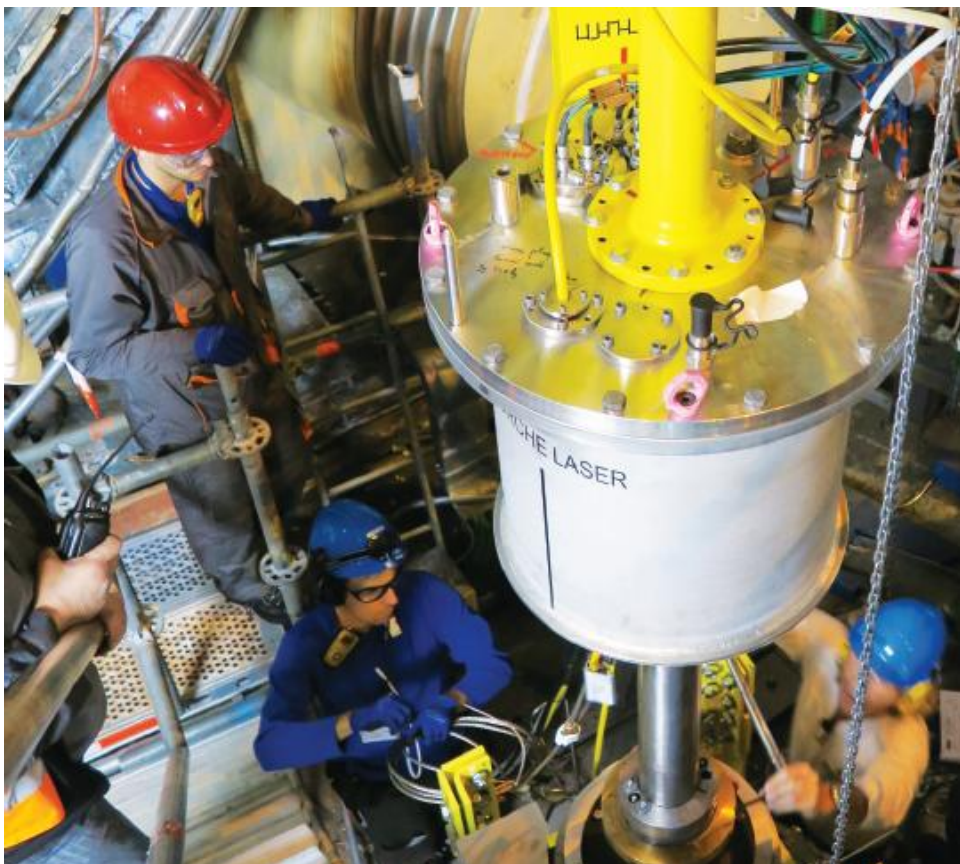
Extrémité d'ELOÏSE avec ses 2 caméras (bouchons éclairés) et la buse de la tête laser (bouchon non éclairé)
