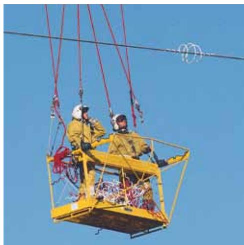
Pose d'une balise avifaune sur une ligne haute tension ; ces dispositifs effarouchent les oiseaux et diminuent les risques d'électrocution.
