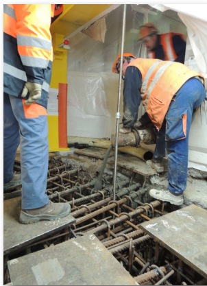
Après la descente du coffrage grâce au palonnier conçu sur mesure (composant jaune sur la photo) et le ferrillage... les équipes réalisent le bétonnage du fond de la piscine autour de la cuve du réacteur.
