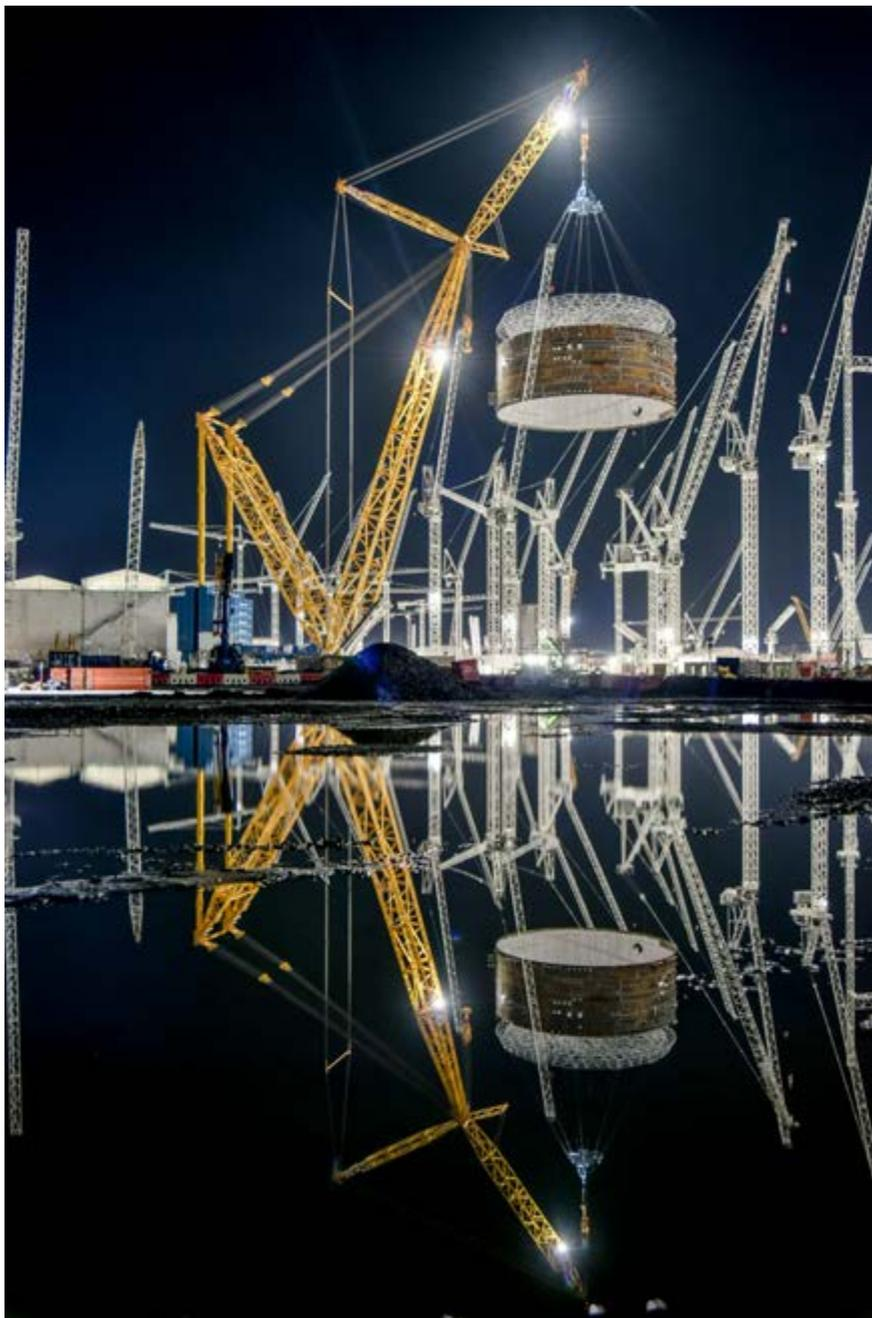
*Levage d'un anneau du liner, bâtiment réacteur 1 de Hinkley Point C*
