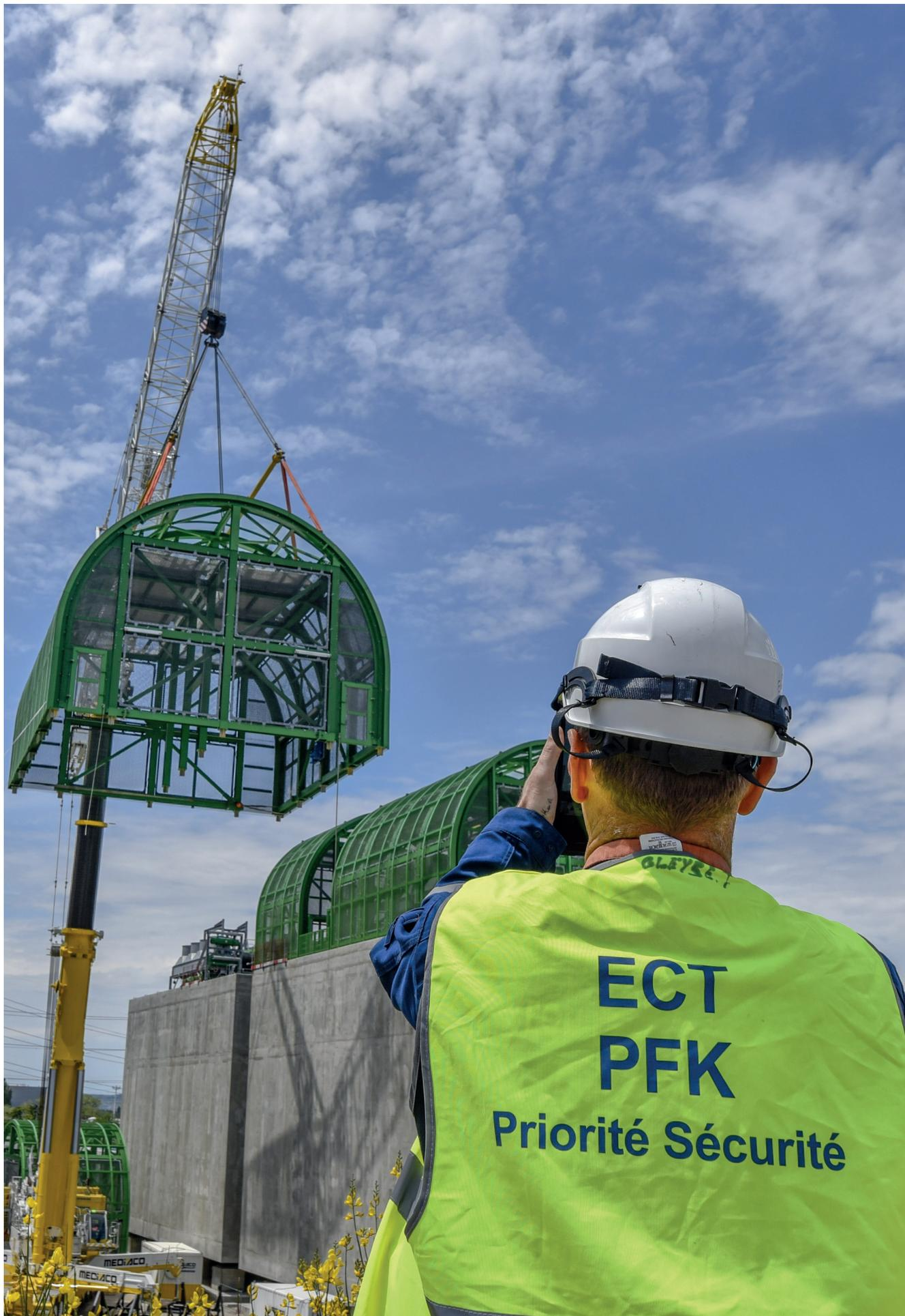
*Mise en place de la charpente métallique du DUS 4.*
