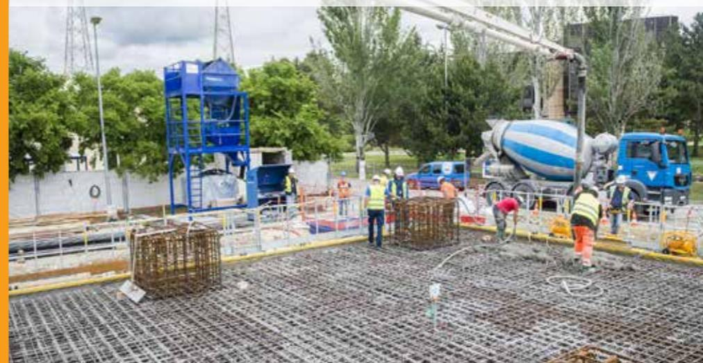
La longueur, le diamètre et la conformité du ferrailage sont vérifiés.
