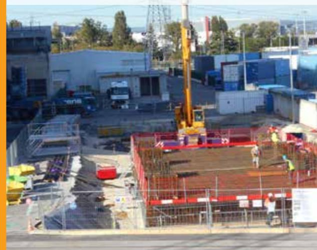
Le sol est renforcé à l'aide de 111 pieux et une dalle de béton armé d'un mètre d'épaisseur supporte 8 plots antisismiques.
