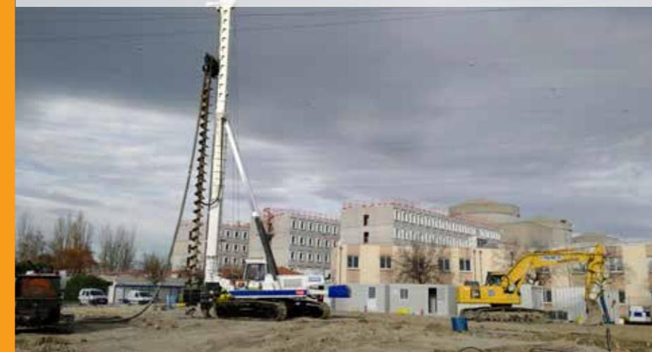
408 tonnes de béton sont coulées sur les 75 tonnes de ferrailage pour construire le radier inférieur de chacun des 4 bâtiments.
