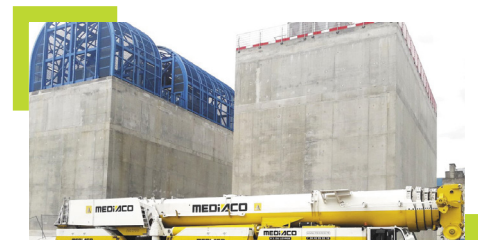
Installation de la charpente métallique sur un DUS de la centrale de Saint-Laurent-des-Eaux.
