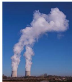
Hautes de quelques 120 mètres, les deux tours aéroréfrigérantes de la centrale nucléaire de Saint-Laurent sont la partie la plus visible de l'installation. Pour autant, elles ne sont pas spécifiques à l'industrie nucléaire, puisque leur rôle est de refroidir la vapeur utilisée dans le cadre de la production d'électricité, qu'elle soit d'origine nucléaire ou non (thermique,
