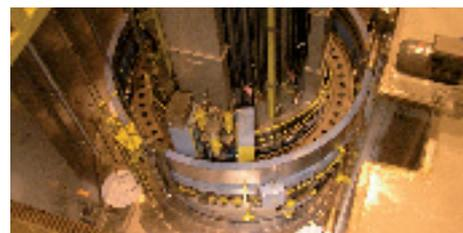
Le dispositif de grappes de commande, visible ici sur le couvercle de la cuve, permet de contrôler la puissance du réacteur.
