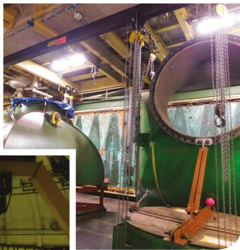
Les équipes du service électromécanique et leur partenaire industriel General Electric ont procédé à la sortie du rotor de l'alternateur en vue de son remplacement. Une pièce de 20 mètres et 240 tonnes.
