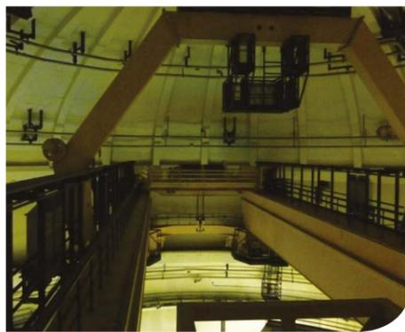
Maintenance décennale du pont polaire. Ce pont de manutention circulaire situé sous le dôme du bâtiment réacteur permet de soulever des charges de 205 tonnes en zone nucléaire : 200 heures sont nécessaires pour remplacer de nombreuses pièces (flexibles hydrauliques, charges d'huile, accouplements...).
