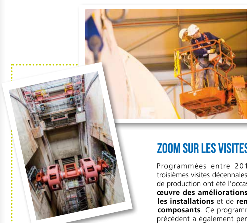
Remplacement de l'arbre d'un tambour filtrant en station de pompage d'eau de mer @EDF-Marc CARAVEO
