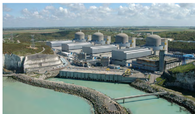
Les quatre unités de production de la centrale nucléaire de Paluel
