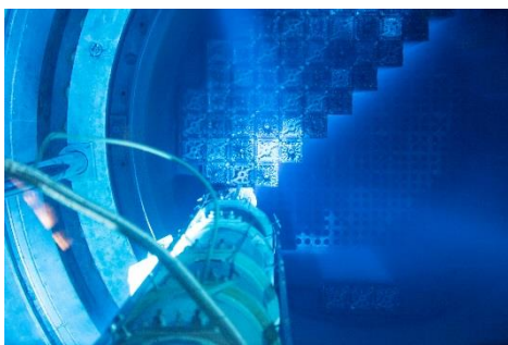
Chargement d'un élément combustible dans la cuve du réacteur.
