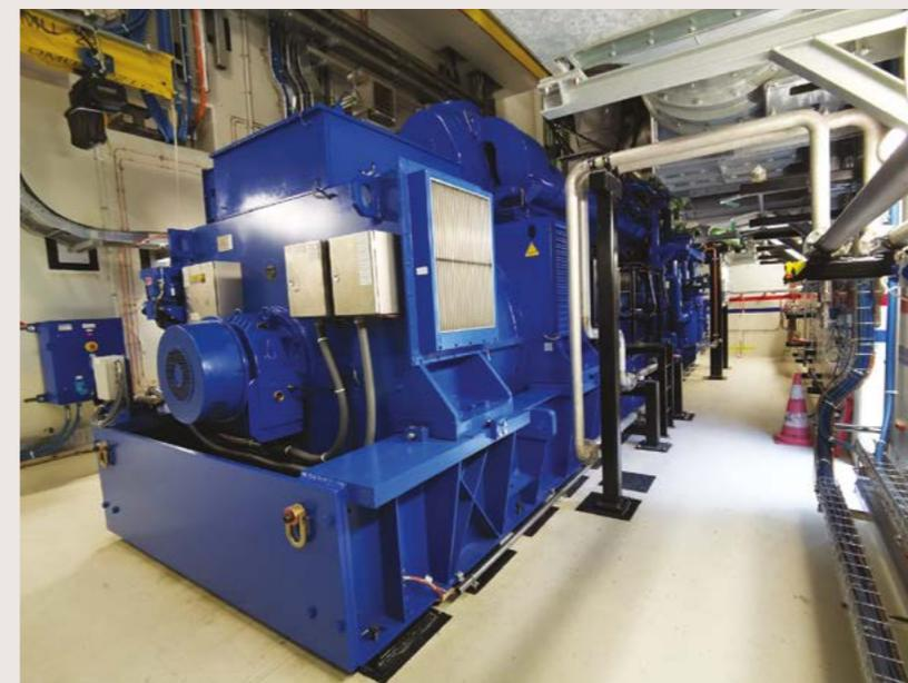
À la suite de l'accident de Fukushima, EDF a défini un ensemble de mesures visant à compléter le dispositif de sûreté existant. La construction de diesels d'ultime secours (DUS), un par réacteur, est l'une d'entre elles. Présentation de ces équipements maintenant pleinement opérationnels à Golfech.
