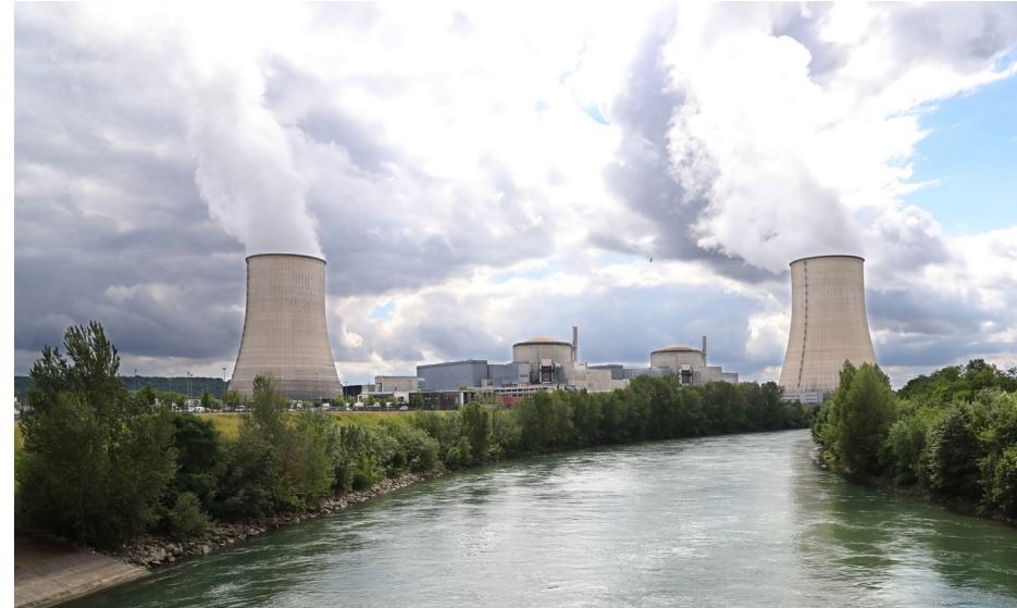
Centrale nucléaire de Golfech
