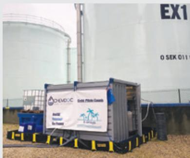
Les équipes de CHEMDOC Water technologies, ont mis en place récemment sur les installations de la centrale nucléaire EDF de Golfech une unité pilote dans le cadre d'une expérimentation. L'objectif : réutiliser de l'eau de circuits de la centrale pour diminuer au maximum l'utilisation du fleuve Garonne.
